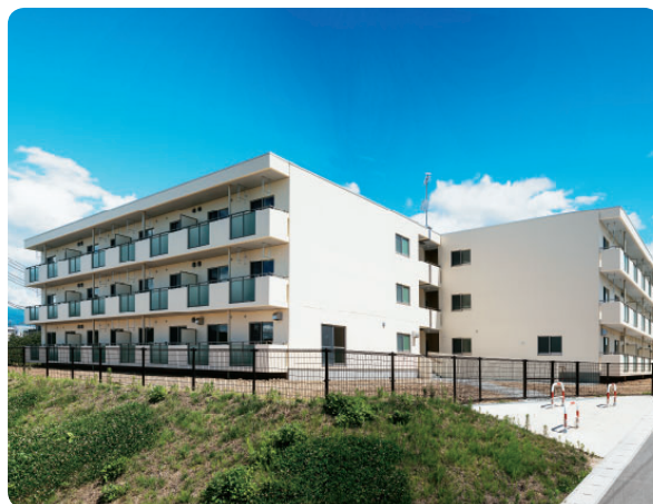
復興公営住宅
