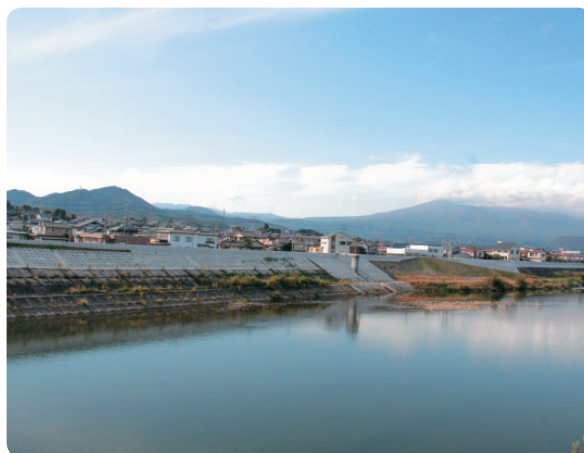
阿武隈川左岸築堤
