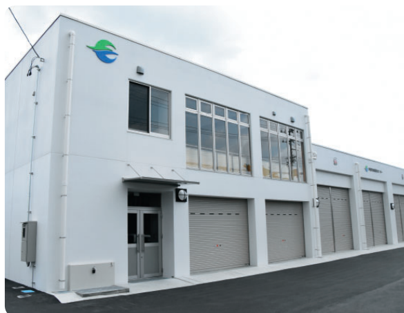
地域防災センター
