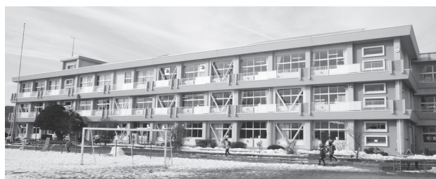
▲五百川小学校校舎耐震化工事
