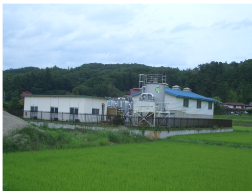
東禅寺浄水場
