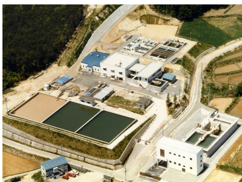
立石山浄水場
