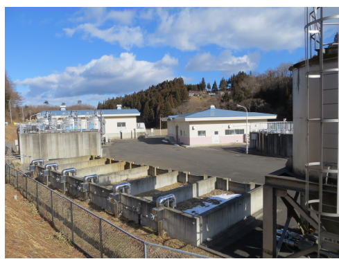
平田石浄水場
