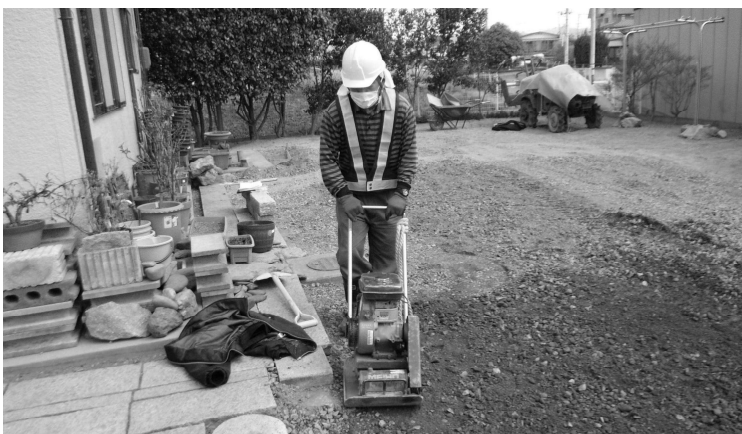
▲高木地区での住宅除染の様子
