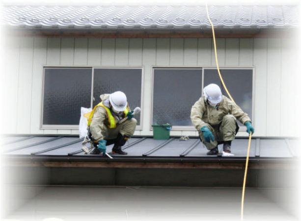
今年3月に行われた住宅モデル除染。雨どいの拭き取りを行う様子
