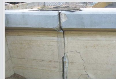
立石山浄水場緩速ろ過池壁面に亀裂が入り、水があふれ出た（写真左）。あふれ出た水で南側法面が崩落（写真右）
