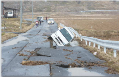
(左)青田地内市道碧森線。道路が陥没し車が落ちている (右)青田字碧森地内、下水道のマンホールが液状化で隆起した
