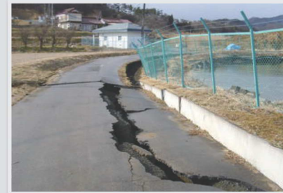
西ノ池貯水池の側道（写真左）に亀裂が入り、池の護岸ブロックが崩落（写真右）
