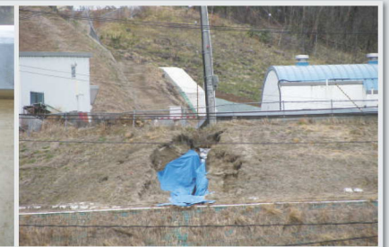
立石山浄水場緩速ろ過池壁面に亀裂が入り、水があふれ出た（写真左）。あふれ出た水で南側法面が崩落（写真右）
