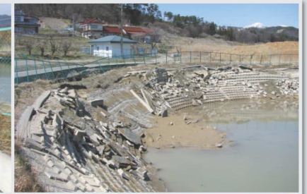
西ノ池貯水池の側道（写真左）に亀裂が入り、池の護岸ブロックが崩落（写真右）
