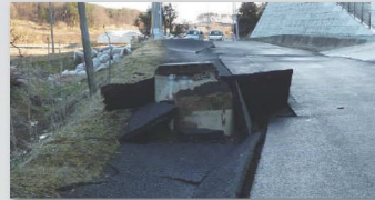
(左)青田地内市道碧森線。道路が陥没し車が落ちている (右)青田字碧森地内、下水道のマンホールが液状化で隆起した
