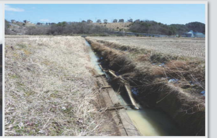
岩根字北原田地内道路（写真左）と水路崩壊（写真右）
