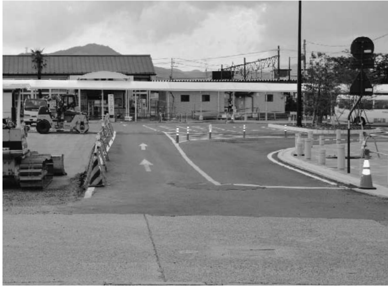
工事が進む本宮駅前東口広場
