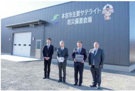
完成した主要サテライト防災備蓄倉庫
