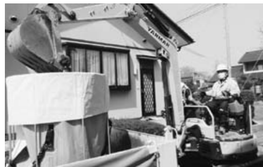
▲住宅除染の様子
